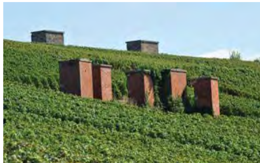
Essors, cheminée d'aération dans le vignoble à Ay - Michel Jolyot
