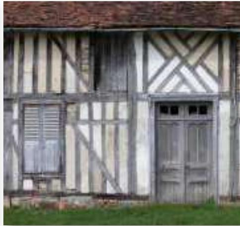
Porte d'entrée à panneaux double vantail et petite imposte vitrée, volets semi-persiennés, porte d'accès au comble, Mesnil-Sellères
