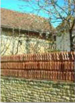
Clôture en tuiles mécaniques de rebut, Montiéramey
