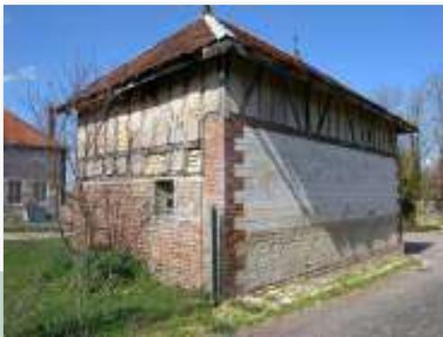
Construction composite : pierre calcaire, craie, brique, pan de bois, apparent à remplissage maçonné enduit, tuile plate, Molins-sur-Aube
