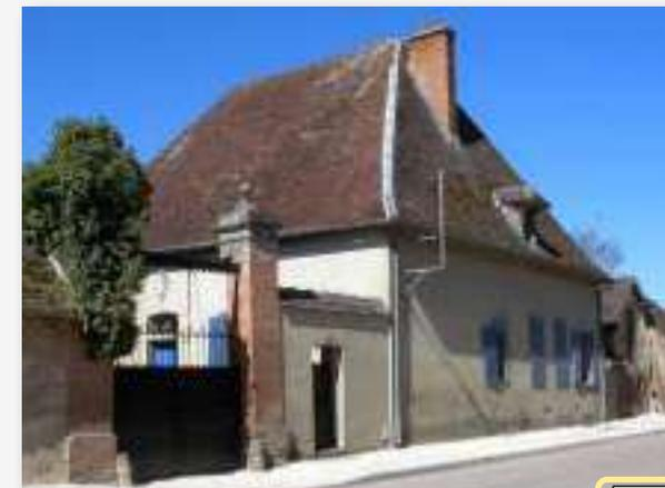
Tuile plate, toiture à quatre pans, façades en maçonnerie,
