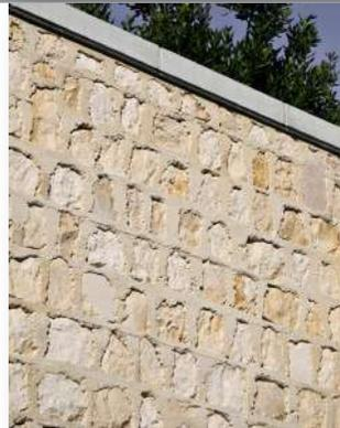
Interprétation contemporaine du mur moellons de pierre calcaire, construction en "pierre banchée" Angoulême (16),
