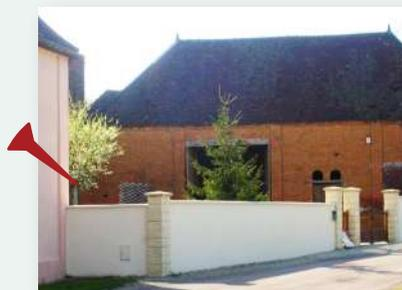
Clôture de parpaing enduit et poteaux de pierre artificielle sont inappropriés à l'architecture de cette belle grange de brique
