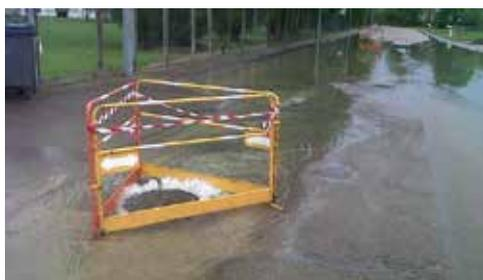
En cas de crue, le risque principal est la remontée des eaux du fleuve par le réseau d'eaux pluviales (photographie ci-contre) : dans l'agglomération, des clapets anti-retour ont été mis en place pour l'éviter.
