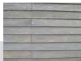
**Essentes** de châtaignier, **bardages** verticaux, horizontaux, avec ou sans recouvrements, avec ou sans couvre joints, habillent les constructions et particulièrement les annexes.
