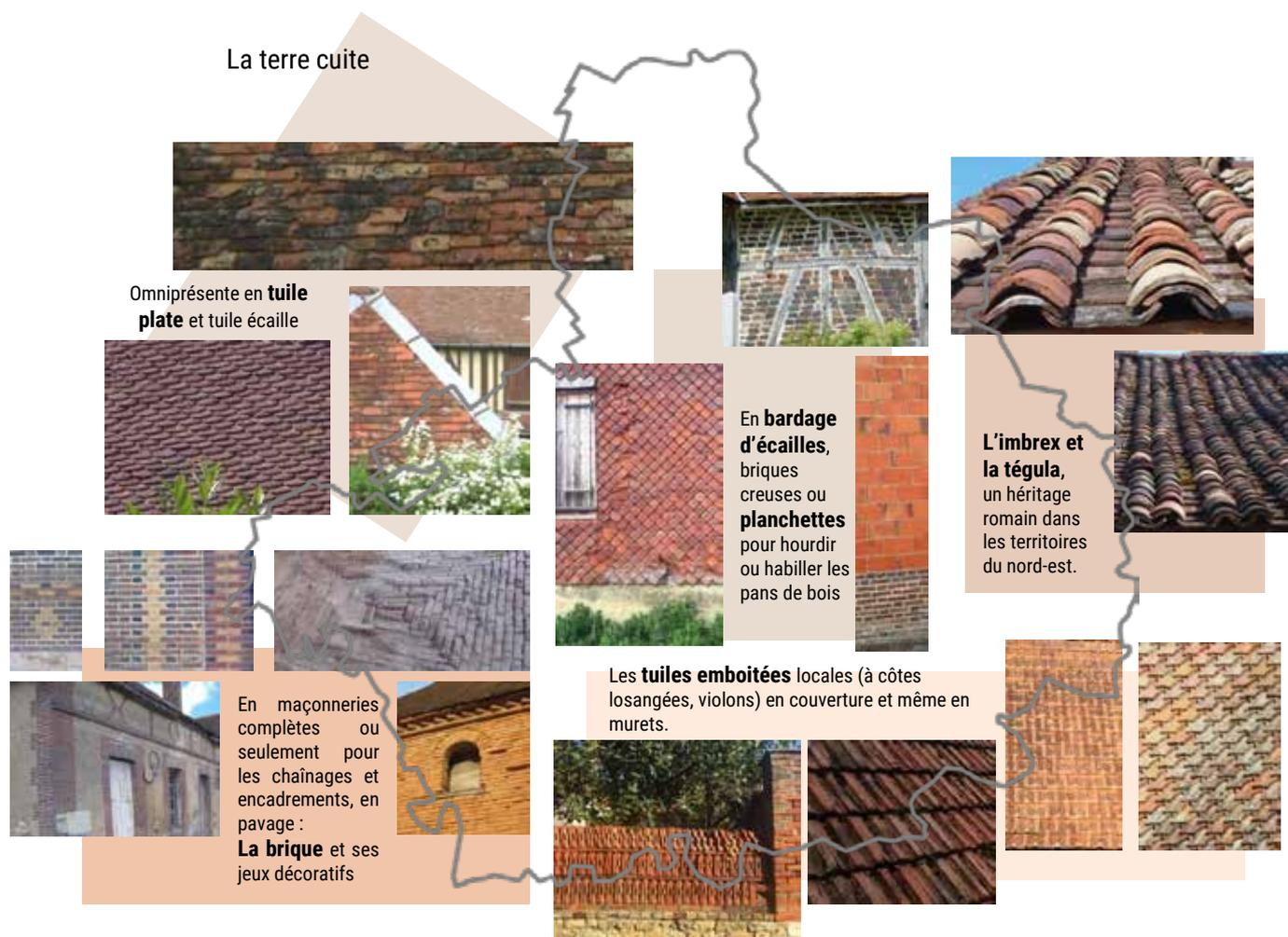
La terre cuite se trouve également utilisée pour le remplissage de pans de bois ou pour couvrir et protéger ses colombages. On voit ainsi des planchettes de terre cuite posées sur champ, formant une paroi fine et légère se surimposant devant les structures en pans de bois et les protégeant, pour les bâtiments les moins prestigieux (granges, souillards, annexes).
