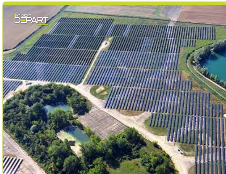
Parc photovoltaïque de Lassicourt
