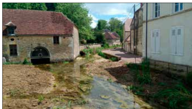
Exemple de renaturation de cours d'eau à Etourvy
